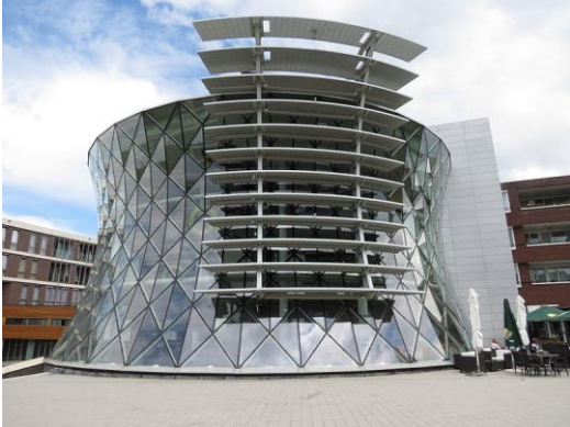
Afbeelding 2. De energiecentrale bevindt zich in de kelder van het cultuurcluster in Heerlerheide Centrum (HHC).
