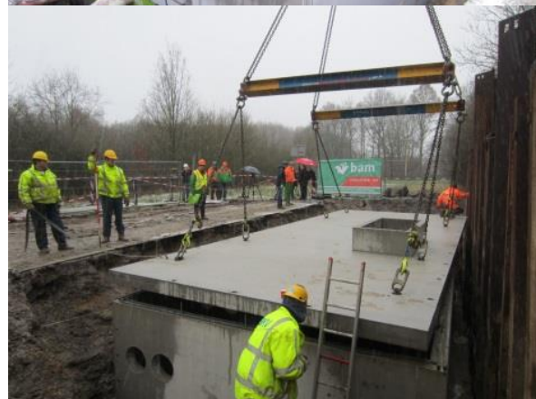
Afbeelding 15, 16 en 17. Het MI-Cluster A wordt geplaatst.
